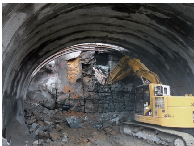
ブレーカによる掘削状況
