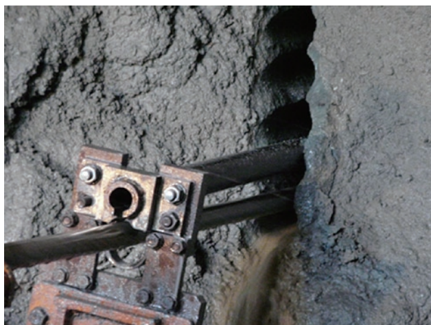
ブレーカによる掘削状況
